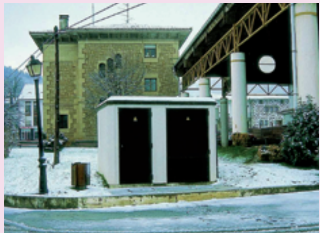
ORMAZABAL PFU-3 transformer substation. Centro de transformación PFU-3 de ORMAZABAL.
