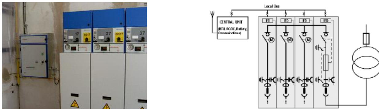
Figura 11: Nuevo concepto de Centro de Transformación automatizado.
