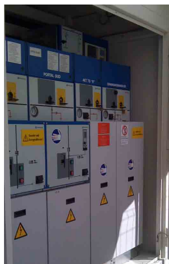
Tunel de Gotthard (Suiza)
